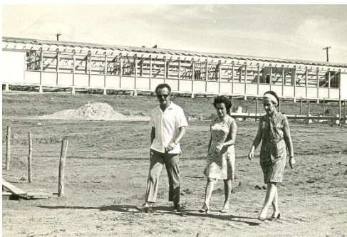
Construção da nova sede – 1970.
