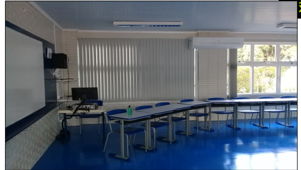
Ar Condicionado Salas EM
