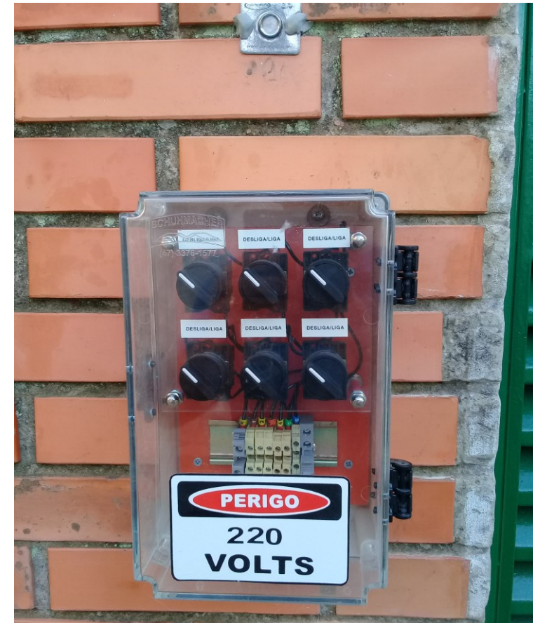
Quadro Acionamento Remoto Iluminação
