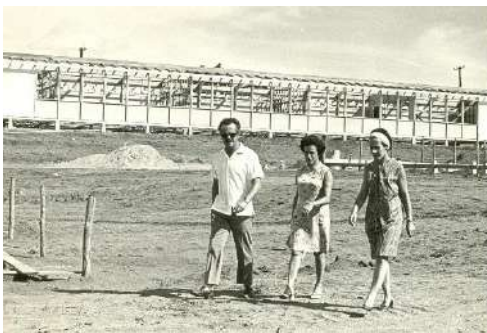
Construção da nova sede – 1970.
